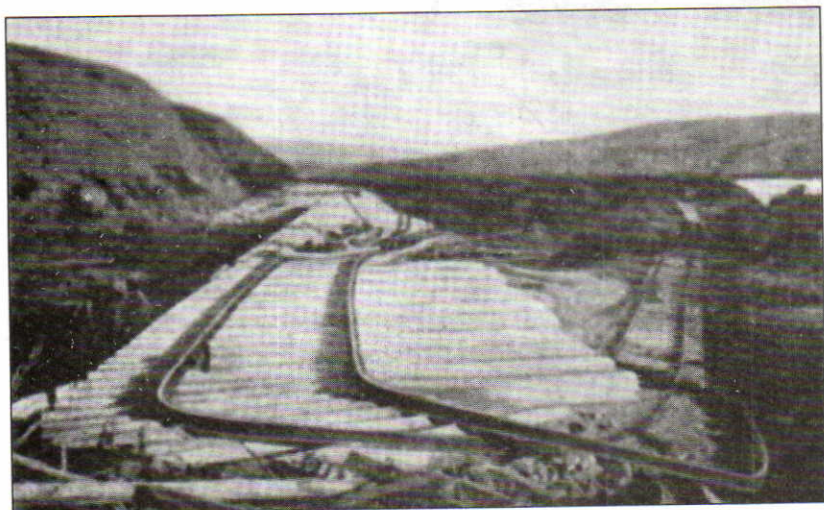
Железная дорога, разрушенная в результате землетрясения
