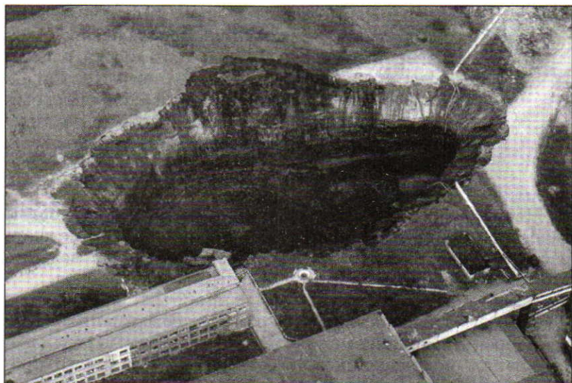
Обвал грунта. Березняки. Пермский край
