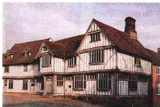
Английский дом. XV—XVI вв. Построен в технике «фахверка» — засыпных, оштукатуренных стен на дубовом каркасе.
